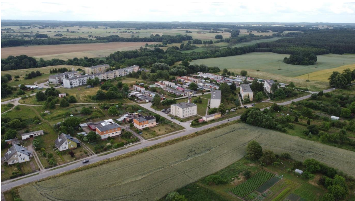
Rysunek 10. Południowa część wsi, widok na dominującą na tym obszarze zabudowę wielorodzinną (zdj. własne)
